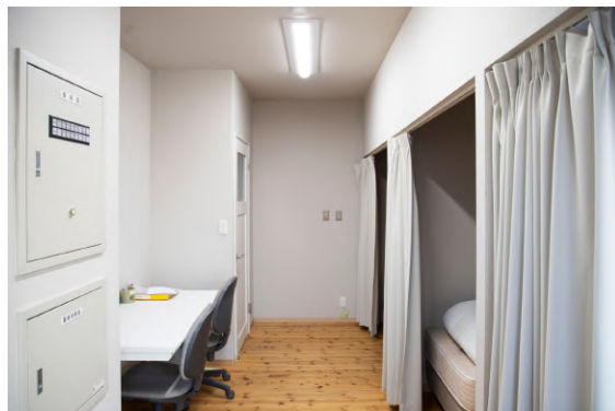
以前使用していた「宿直室」。ベットが用意されており、いつでも対応できる体制を整えていたが、現在は使用していない。
